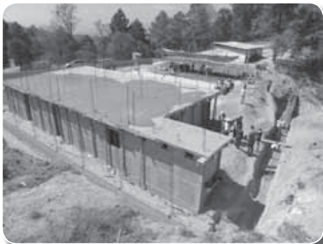
Eine neue Schule entsteht. - Im Hintergrund die Blechhütte, die jetzt als Schulgebäude dient.
