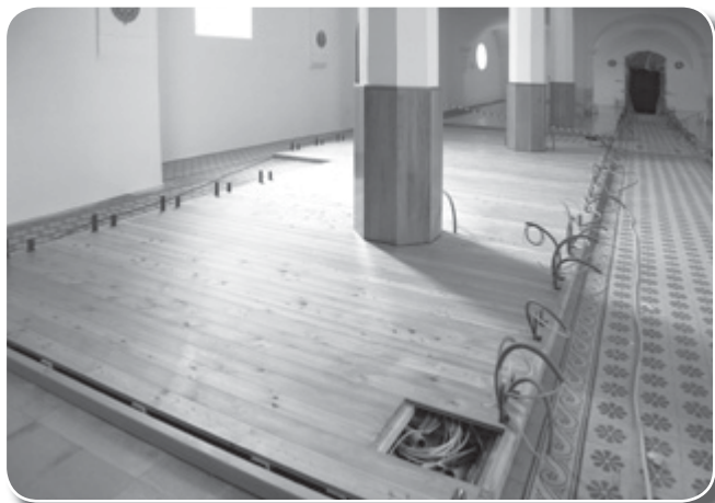
Holzboden, Säulenverkleidung und jede Menge elektrische Installation für die Heizung
